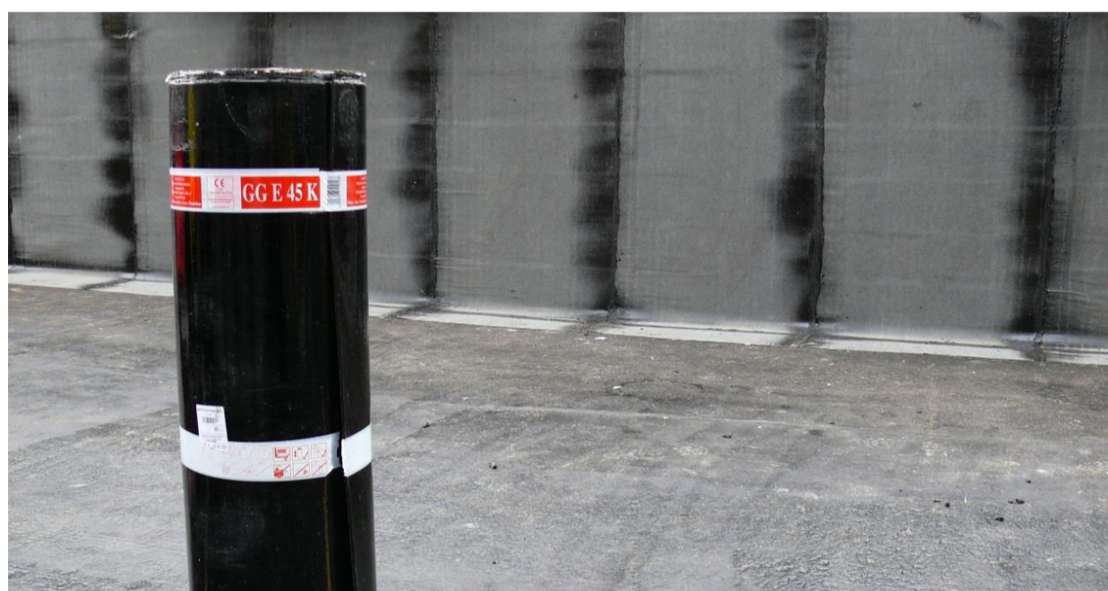
Apartmanház pinceszigetelése, Sárvár
