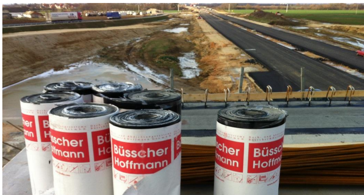
M35 hídszigetelés HÍD-2 rendszerrel
