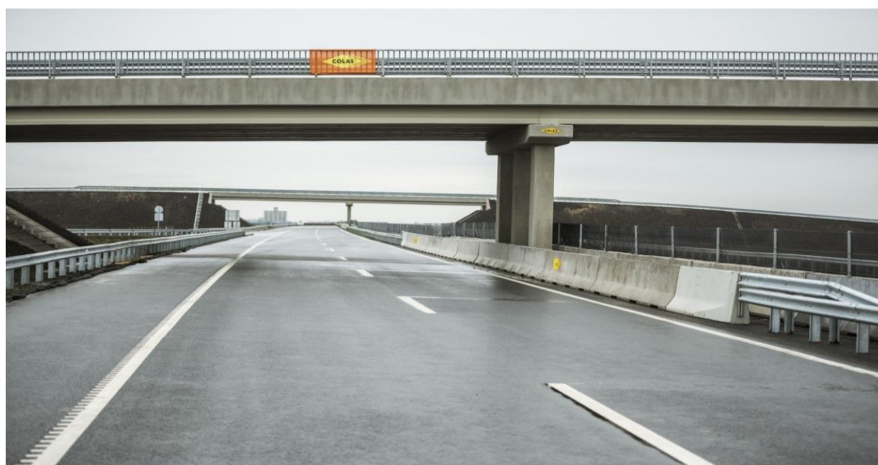
M86 hídszigetelés HÍD-2 rendszerrel
