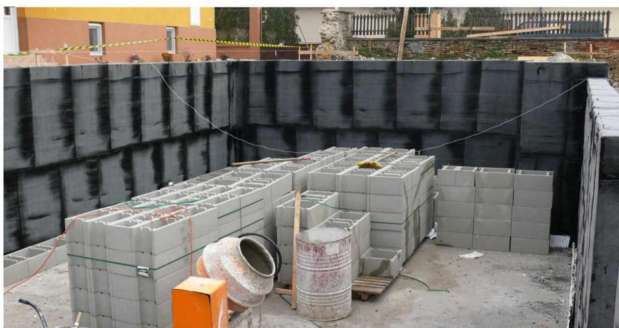
Apartmanház pinceszigetelése, Sárvár
