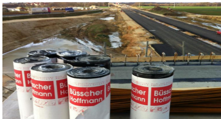
M35 hídszigetelés HÍD-2 rendszerrel
