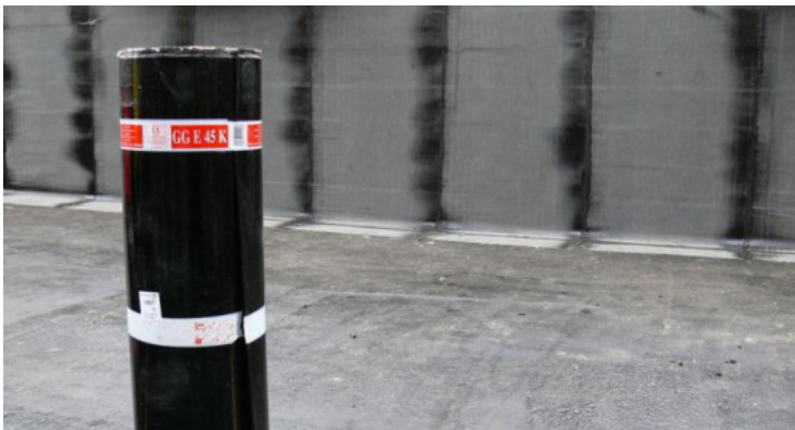
Apartmentház pincészigetelése, Sárvár
