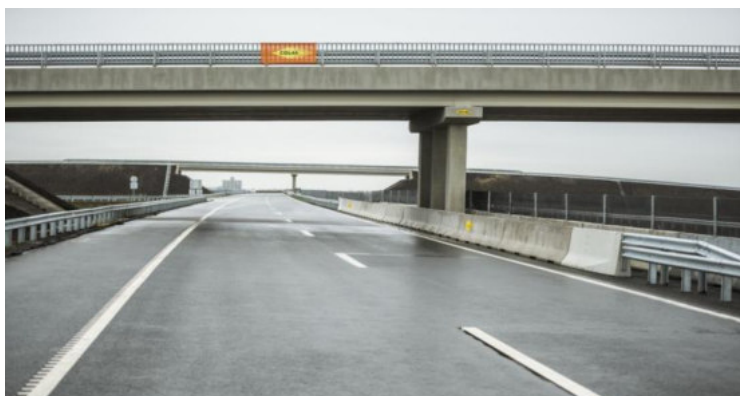
M86 hídszigetelés HÍD-2 rendszerrel
