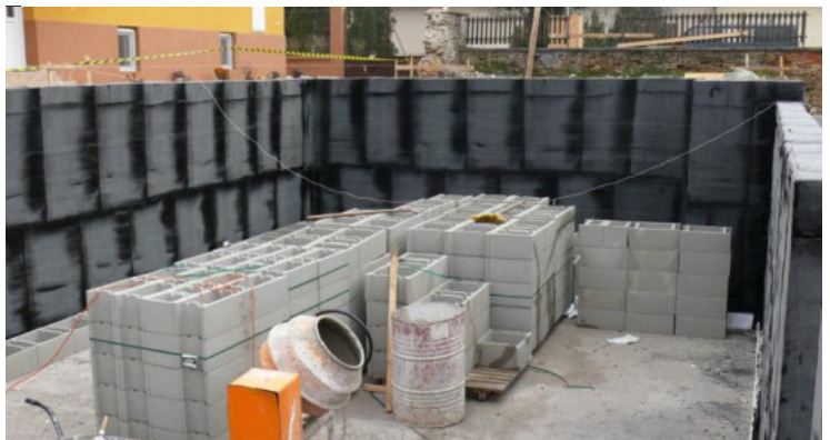
Apartmentház pincészigetelése, Sárvár
