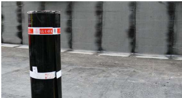
Apartmentház pincészigetelése, Sárvár
