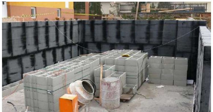
Apartmentház pincészigetelése, Sárvár
