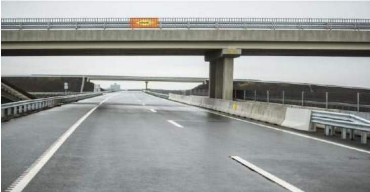
M86 hídszigetelés HÍD-2 rendszerrel
