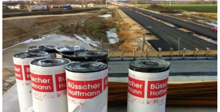
M35 hídszigetelés HÍD-2 rendszerrel
