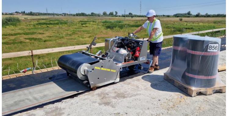
M3 hídszigetelés jumbo terekcsekkel
