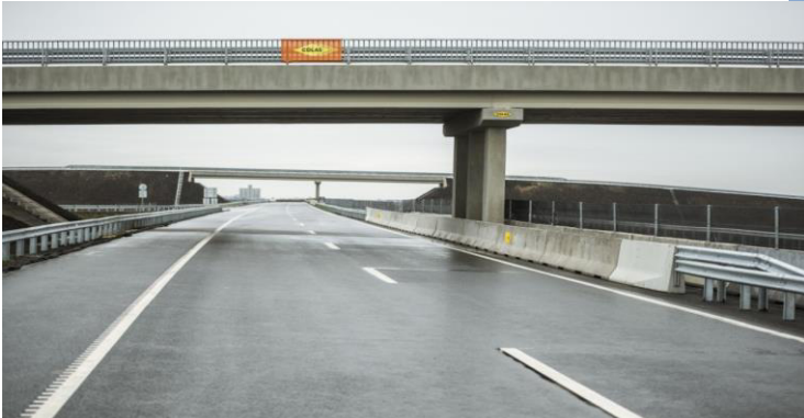
M86 hídszigetelés HÍD-2 rendszerrel
