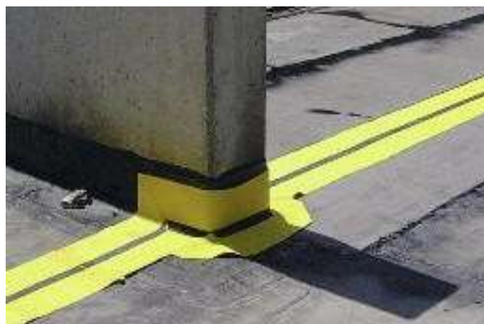
Benzile și elementele profilate se livrează ca sisteme gata confecționate pe șantierul dumneavoastră și urmăresc traseul fiecărui rost.
