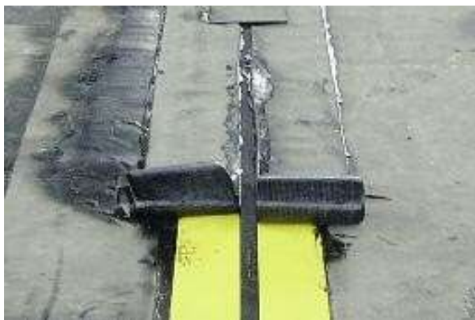
Montaj la același nivel (fără bucle și umflături deranjante)
