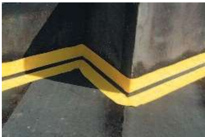
Benzile și elementele profilate se livrează ca sisteme gata confecționate pe șantierul dumneavoastră și urmăresc traseul fiecărui rost.
